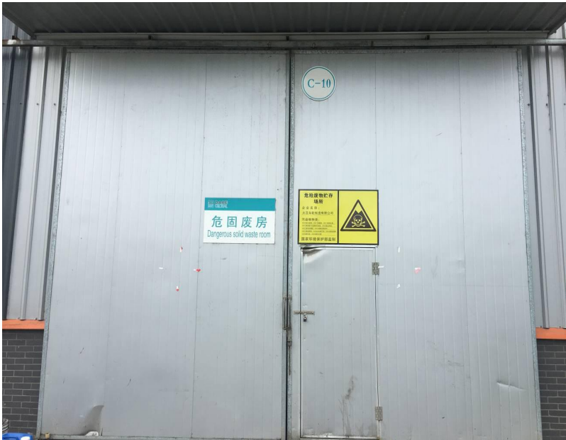
图 4.1.1-1 危险废物暂存处
